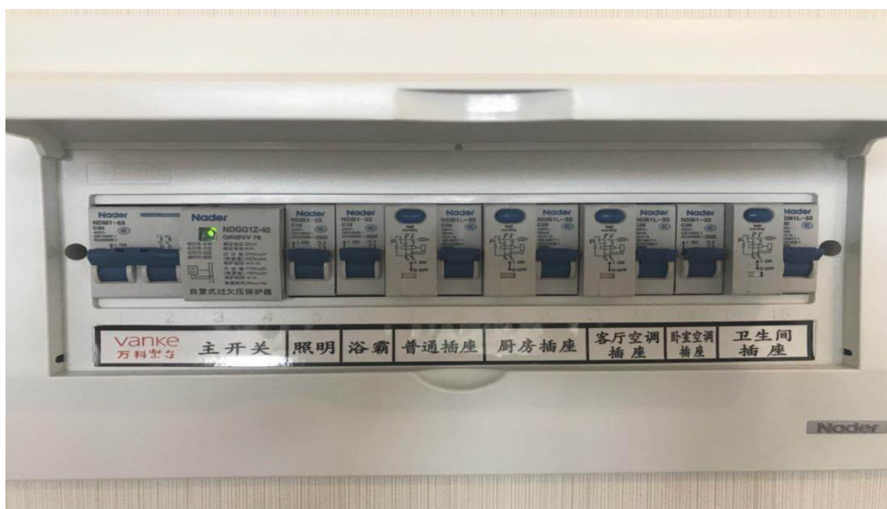
(*) 户型户内配电箱回路控制示意图
