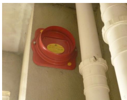
(*) 户型排烟(气)道、防火止回阀布置图
